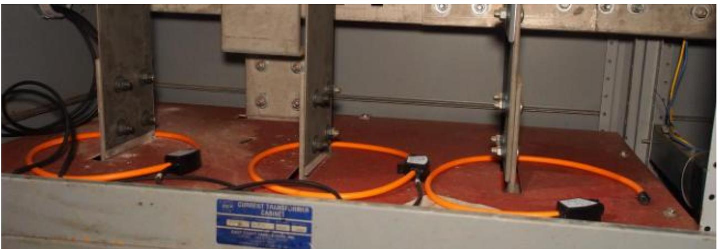
Conecte os TCs no medidor localizado no interior da caixa EDGEBOX. Abaixo da caixa existem dois furos para acesso de eletrodutos. Utilize um eletroduto separado para os TCS e comunicação e outro para alimentação da caixa.
